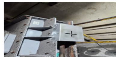
리들링컨베이어 회전체 커버 설치
